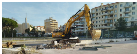
Le constructeur Dassé a déjà initié les chantiers des crèches de Cherbourg (50) et Toulon (83) dont les livraisons sont prévues pour septembre 2024. Suivront prochainement ceux d'Evreux (27) et Varces (38).
